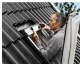
Montaggio del pannello solare con sensore pioggia integrato
