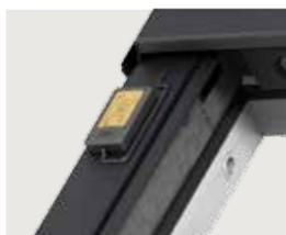
Sensore pioggia sul lato esterno con finestra per tetti elettrica installata successivamente
