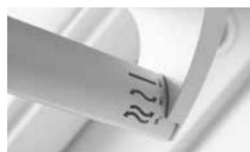
La straordinaria maniglia d'aerazione permette il ricircolo di aria fresca, anche se la finestra è saldamente chiusa. Anche con questo tipo di finestra, il meccanismo di ventilazione è dotato di un filtro intercambiabile che trattiene polvere ed insetti.
